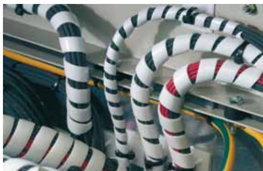
Bild 7: Getrennte Bündelung von Leitern
