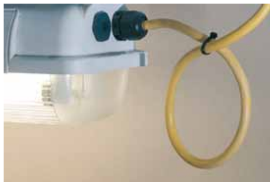
Bild 5: Kabelschleife schützt vor Eindringen des Wassers
