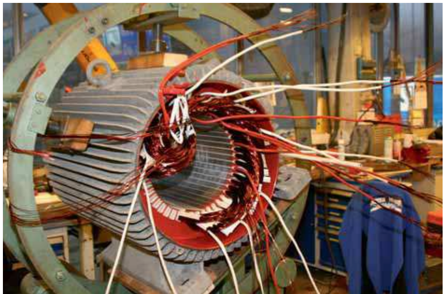
Bild 2: Neuanfertigung der Statorwicklung an einem der Zündschutzart Erhöhte Sicherheit »e«-Motor
