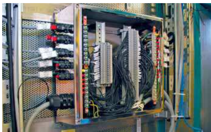
Bild 4: Klemmenkästen Typreihe 8125 (geöffnet)
